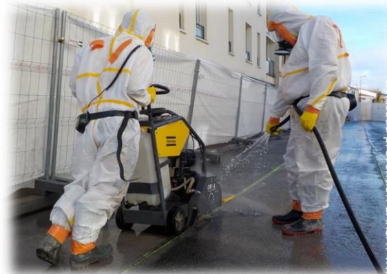
Sciage pour réparation de canalisation Sous-section 4
