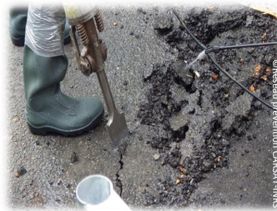
Burinage pneumatique lors de réparation de chaussée Sous-section 4
