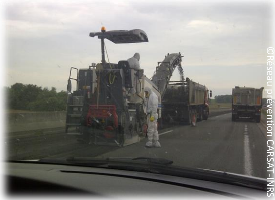
Fraisage lors de la réfection des routes- autoroutes – pistes d'aviation Sous-section 3
