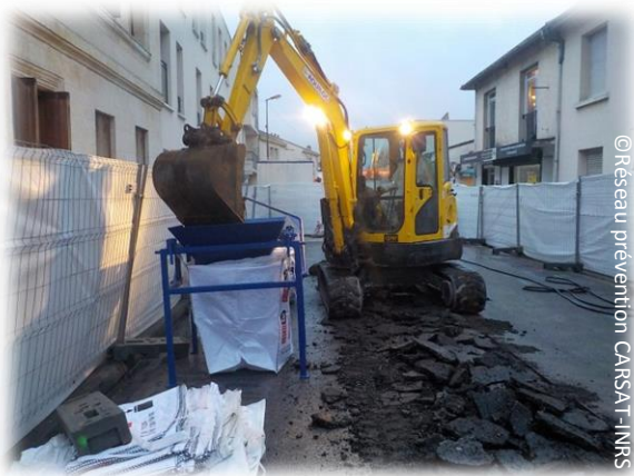
Pelletage des plaques à la pelleteuse Sous-section 3
