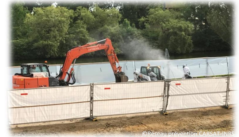
©Réseau prévention CARSAT-INRS Isolement de la zone d'intervention - Canon d'arrosage lors de décroûtage – Pelleteuse équipée d'une cabine pressurisée
