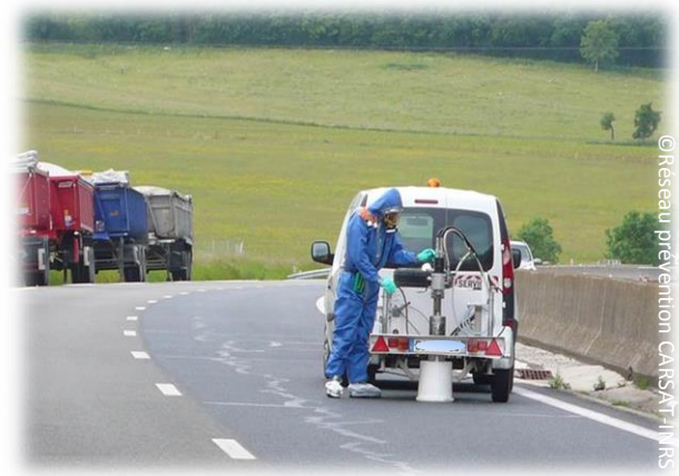
Carottage pour identification de la présence d'amiante Sous-section 4
